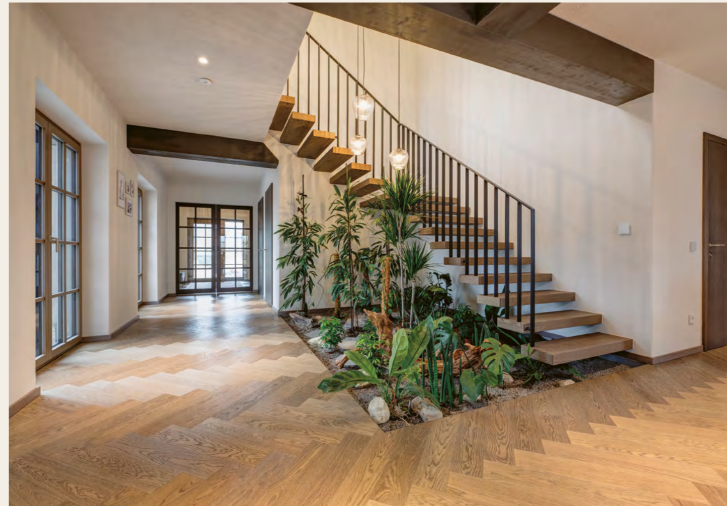
Kragarmstiege und Flachstahlgeländer mit senkrechter Flachstahlfüllung
