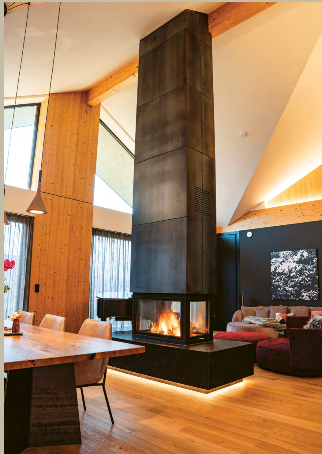
Offener Kamin mit 4-seitigem Sichtfenster, Sonderkonstruktion mit Stahlverkleidung und Natursteinbank
